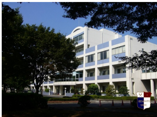
図3 北里大学医療衛生学部 A3 号棟の外観
